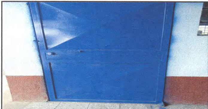
Foto 6: Aspecto de las puertas de las aulas después de haberse pintado.
