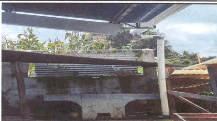
Foto 2: Sustitución de canales y bajadas de aguas pluviales.
