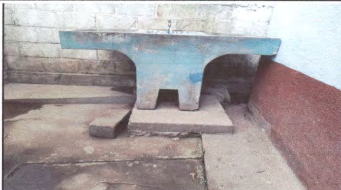
Foto 1: Mejoramiento del drenaje y tubería de una de las pilas..
